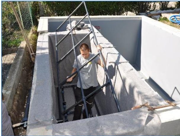
Bubble Leitung in den Skimmerteich einbringen
