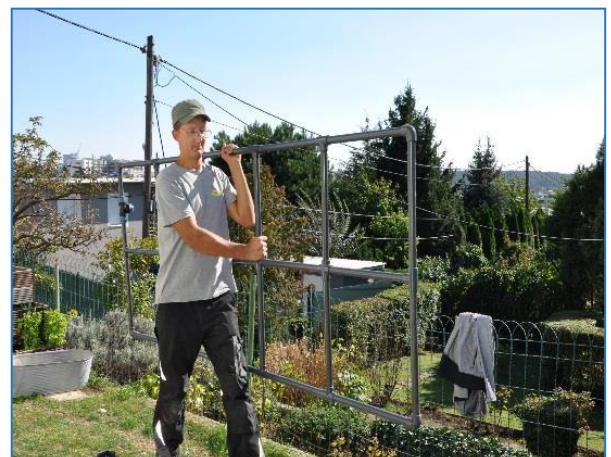
Als nächstes Bubble Leitung einbringen
