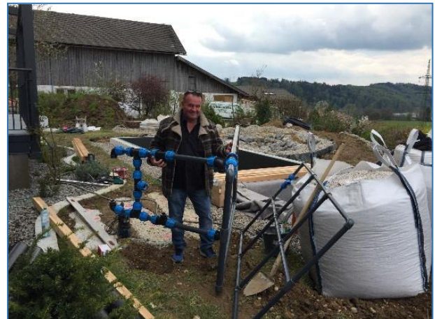
Einbringen der Rückspülleitung und des Filtergestelles
