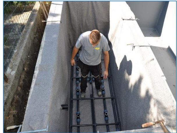
Bubble Leitung auf die bereits eingebrachten Leitungen legen
